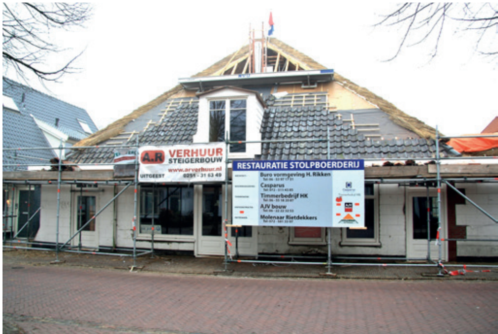
Restauratie van een stolpboerderij in Bergen
