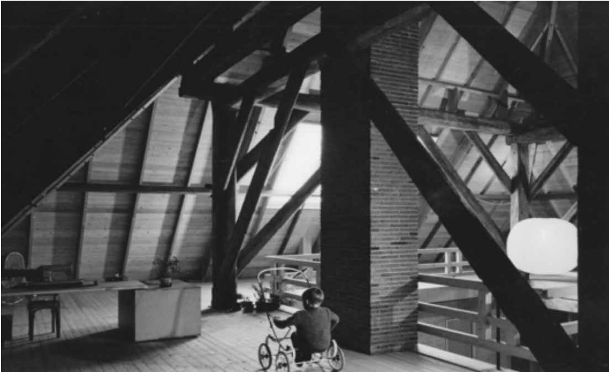
De nog ongebruikte verdiepingsvloer in 1964
