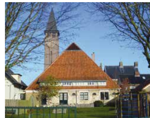
Langgerekte dakkapel en raam in top toegevoegd, Grootebroek
