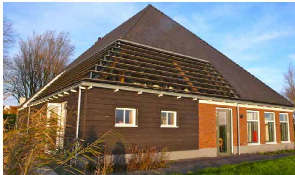
Een grote lichtopening in het dak, Starnmeer
