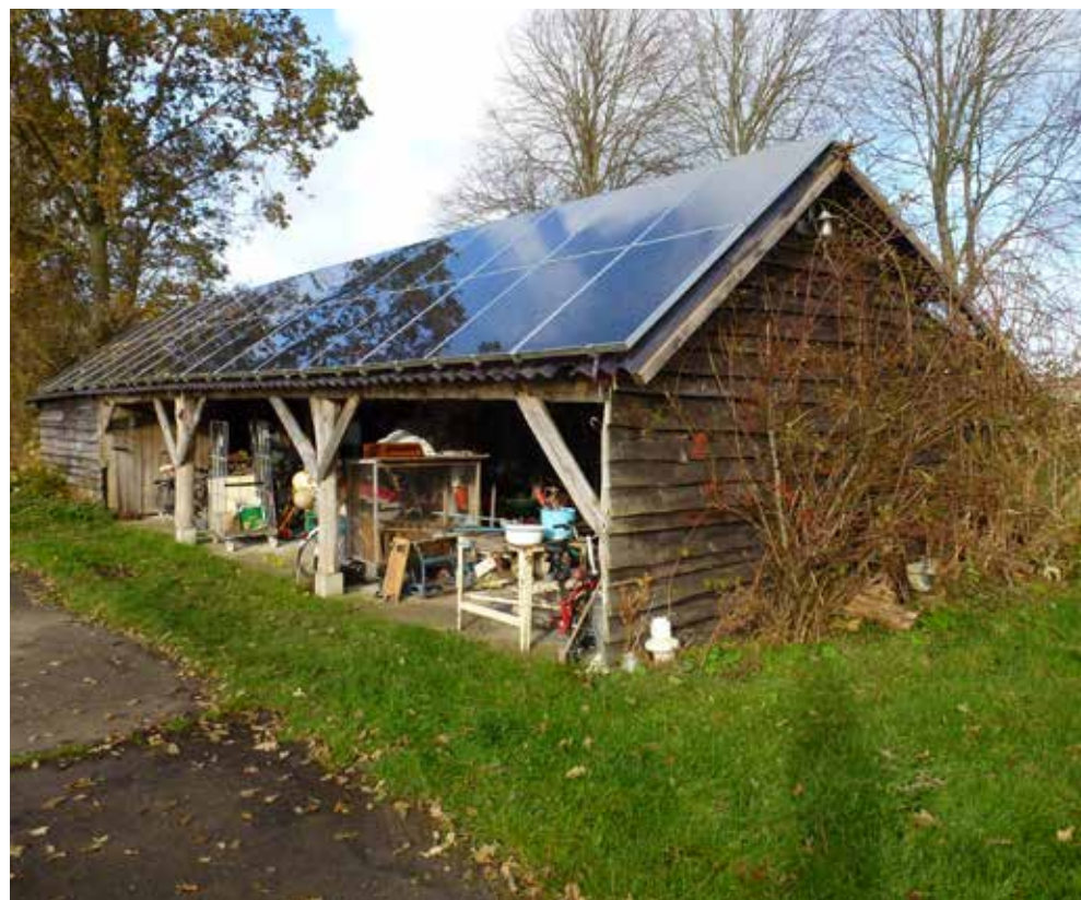
Zonnepanelen op bijgebouw, Spierdijk
