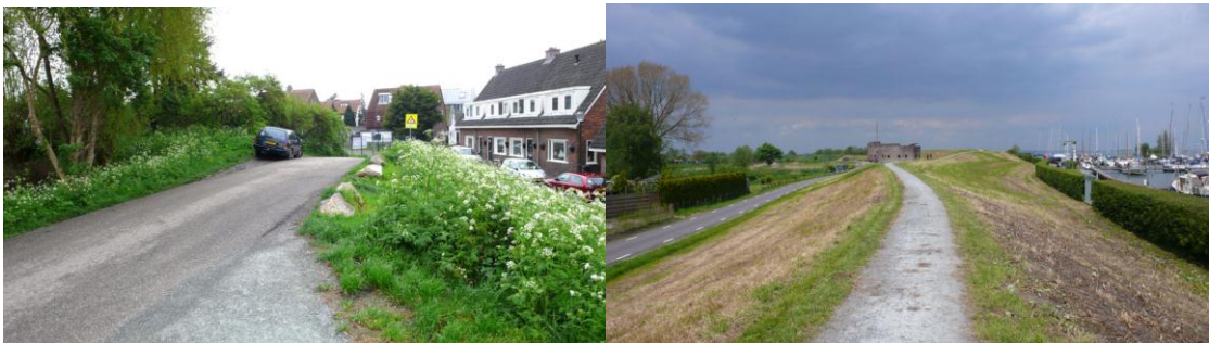
Hooggelegen einde van de vestingwal bij de Westzeedijk, en de Westzeedijk met Westbatterij
